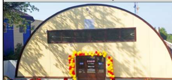
СКЛАДСКИЕ И ПРОИЗВОДСТВЕННЫЕ ПОМЕЩЕНИЯ
