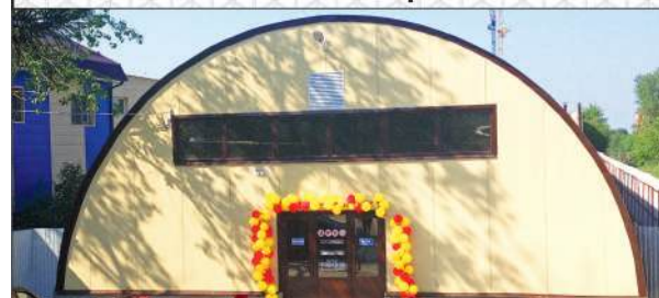
СКЛАДСКИЕ И ПРОИЗВОДСТВЕННЫЕ ПОМЕЩЕНИЯ
