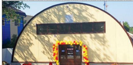
СКЛАДСКИЕ И ПРОИЗВОДСТВЕННЫЕ ПОМЕЩЕНИЯ
